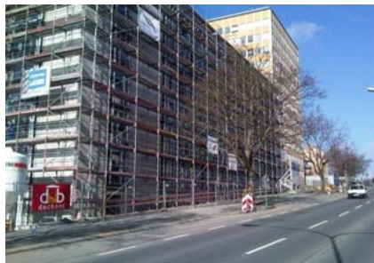
Hof, Zentrales Justizgebäude 1. BA AG: Pazdera AG, Coburg
